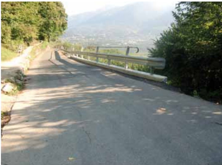
Erneuerung des Straßenbankettes in der Lebenbergerstraße
