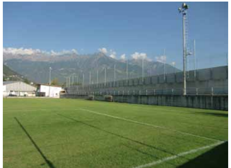
Erhöhung des Ballfangnetzes zur Verbesserung der Sicherheit entlang der MeBo
