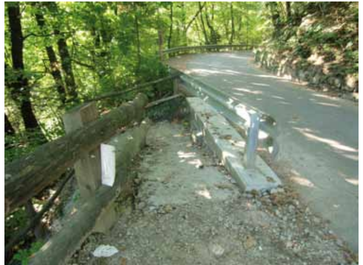
Verlängerung der Leitplanken mit Hangsicherung für einen sicheren Zugang vom Parkplatz zum Waalweg
