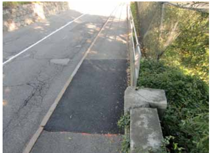
Asfaltausbesserungen wie hier in der Nörderstraße wurden an verschiedenen Straßenstücken durchgeführt.
